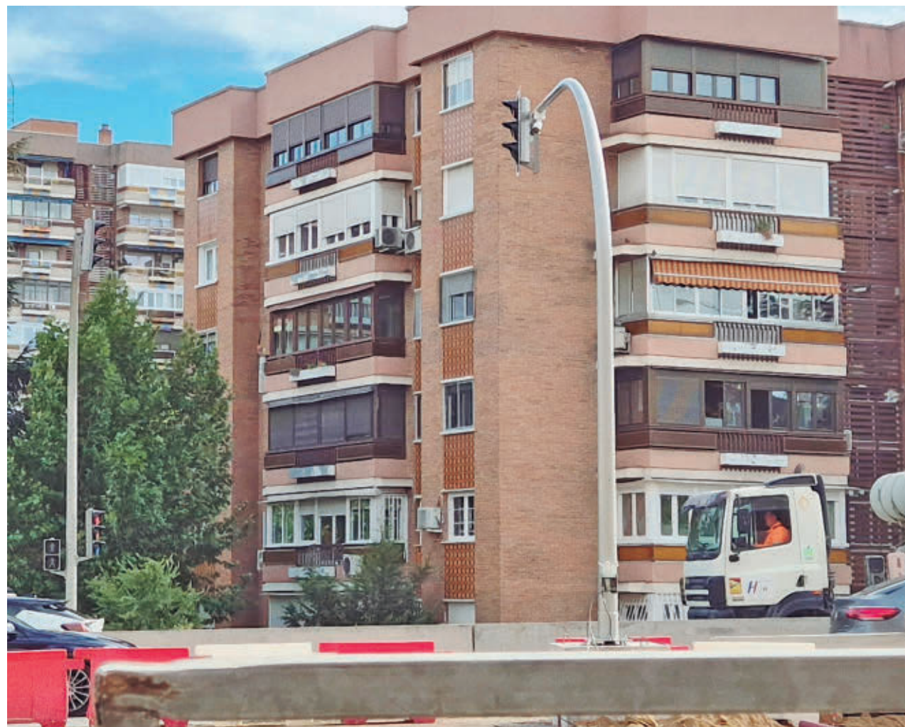
SEGUIMOS OBRAS A5
