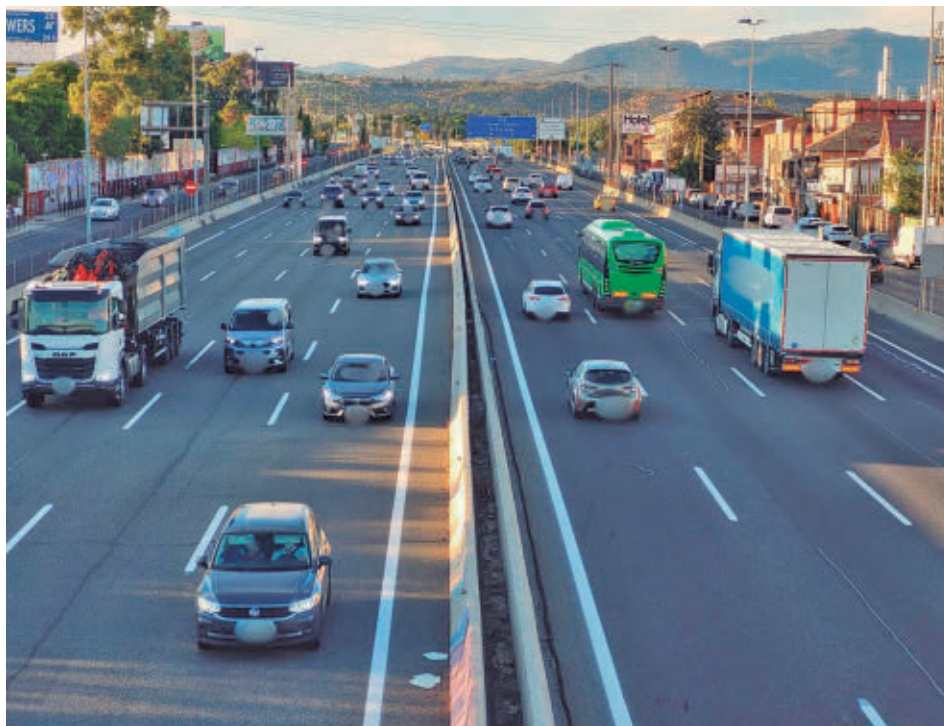
La autovía A-6 a su paso por la localidad de Las Rozas
