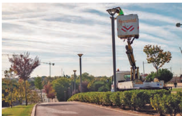
Los trabajos de instalación de las nuevas luminarias
