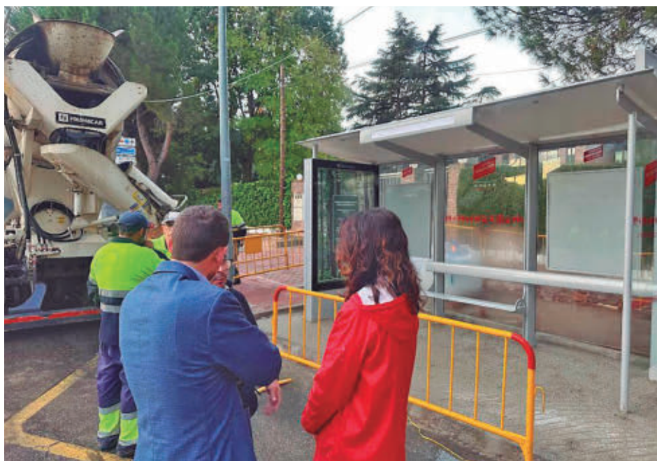
Las obras mejoran la seguridad, comodidad y accesibilidad de los usuarios AYTO DE ALCORCÓN
