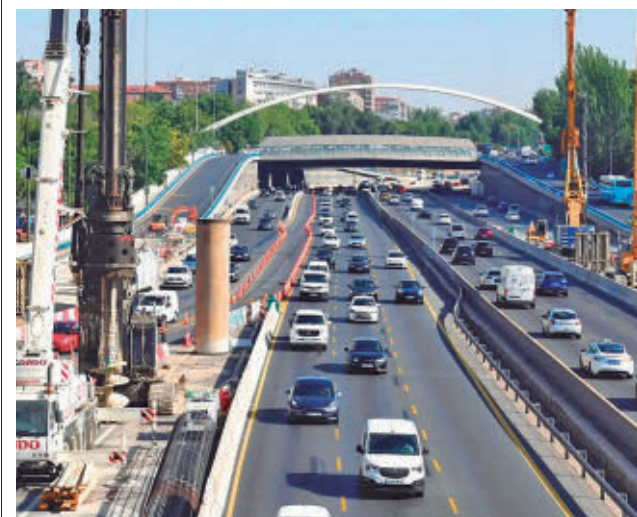
Las obras de Parque Ventas
