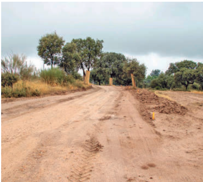
Estado actual de las obras
