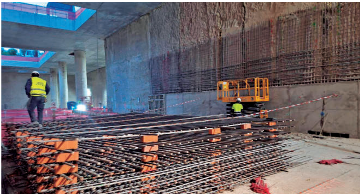
Los trabajos de ampliación de la Línea 11 del suburbano madrileño @TRANSPORTES_CM
