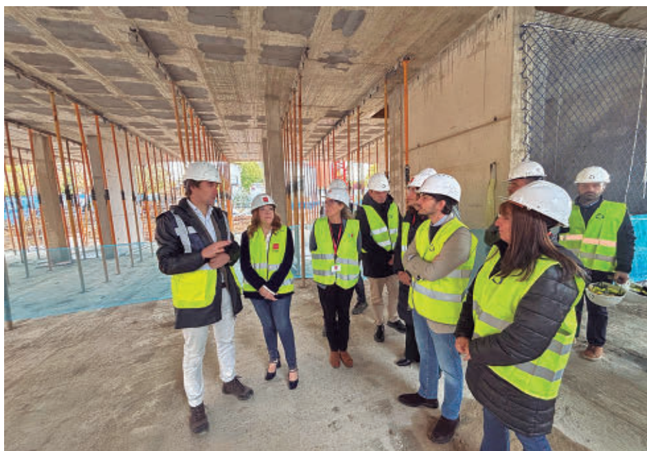
Visita institucional a las obras COMUNIDAD DE MADRID
