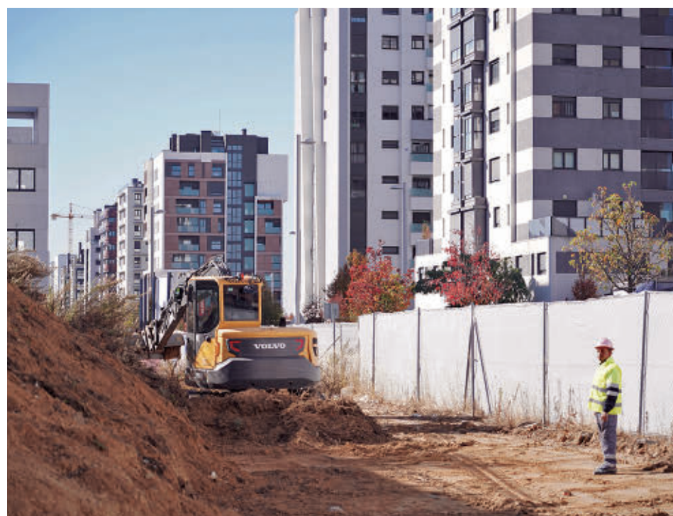
Las obras de la futura dotación cultural del nuevo barrio vicalvareño
