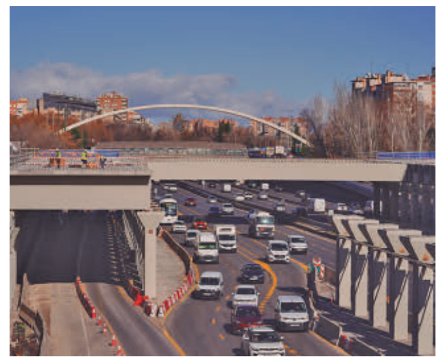
Estado actual de las obras
