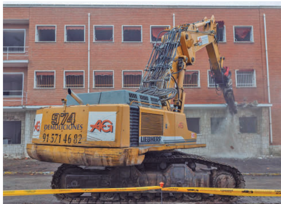
La excavadora trabaja en uno de los edificios
