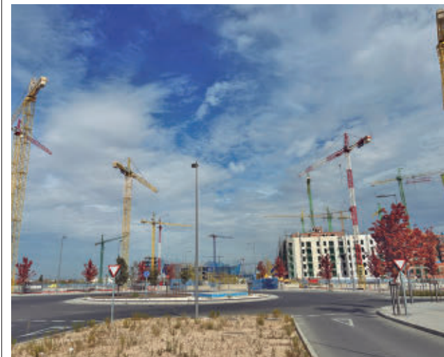
Construcción de pisos en el barrio de Los Berrocales M. A. N.
