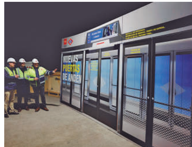
Instalación de una puerta en Legazpi
