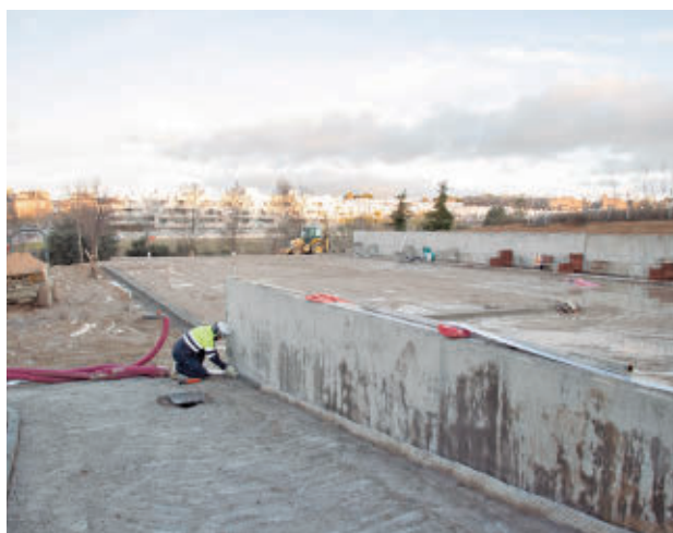
Las obras de construcción de la zona deportiva
