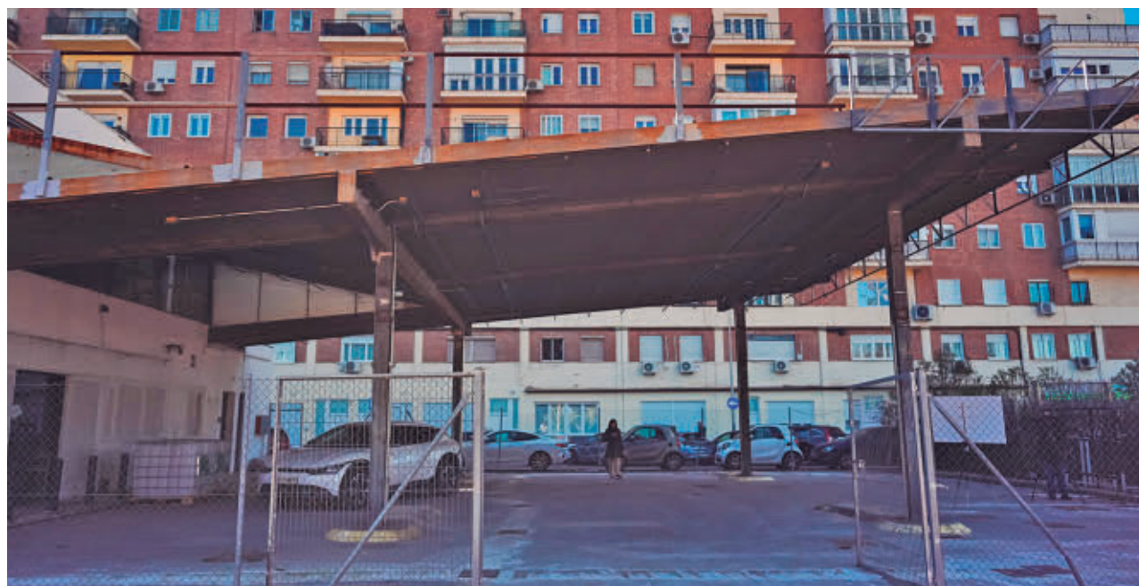
Espacio en el que se instalará la nueva electrolinera
