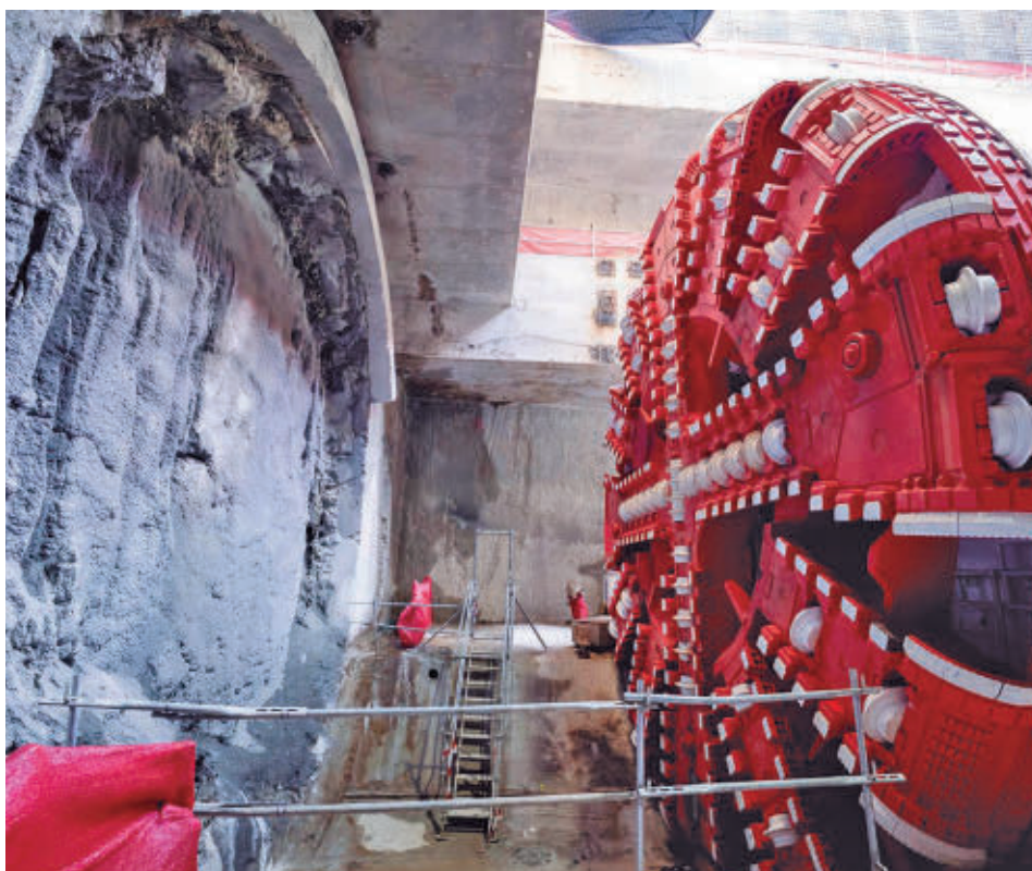
La tuneladora está a punto de empezar a trabajar E. P.
