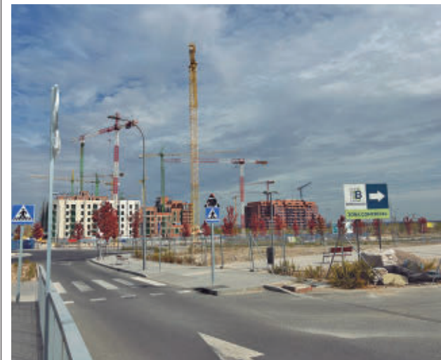
Obras de construcción en Los Berrocales M. A. N.
