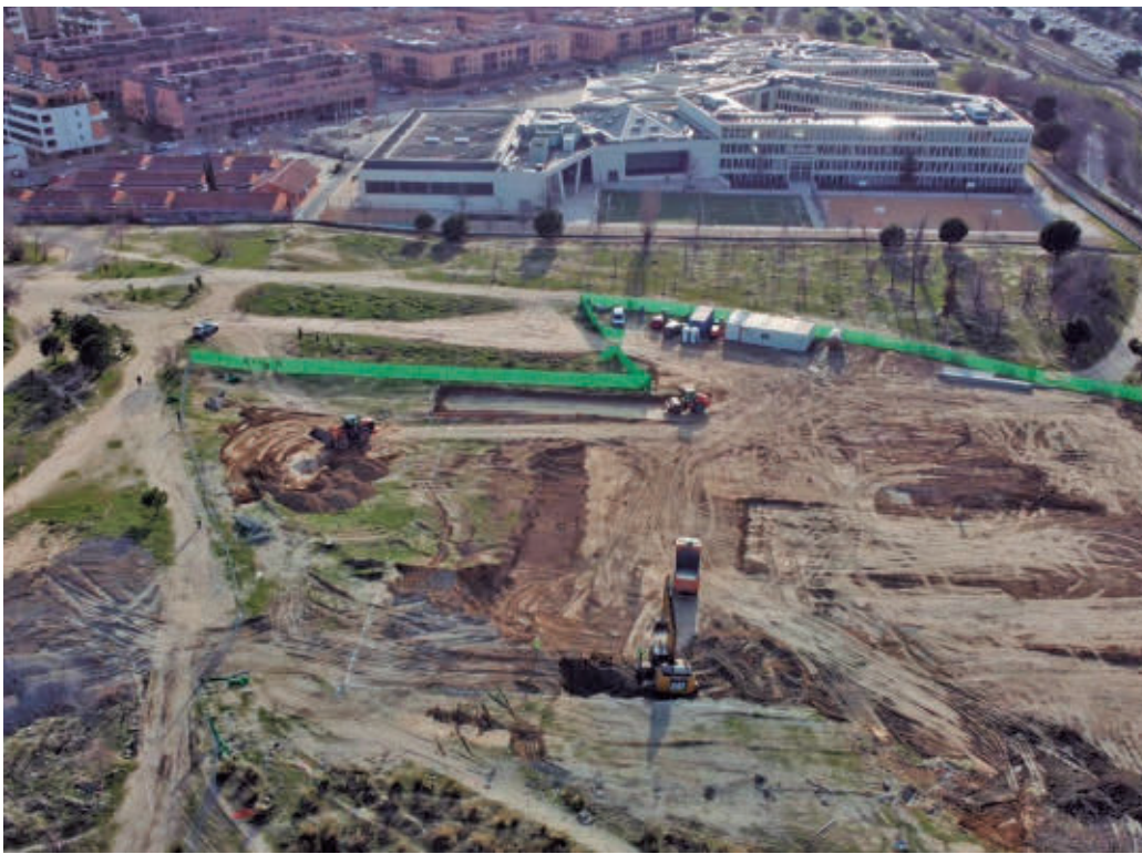
Estado de las obras en el solar donde se ubicaría esta instalación @NOMEGACANTON
