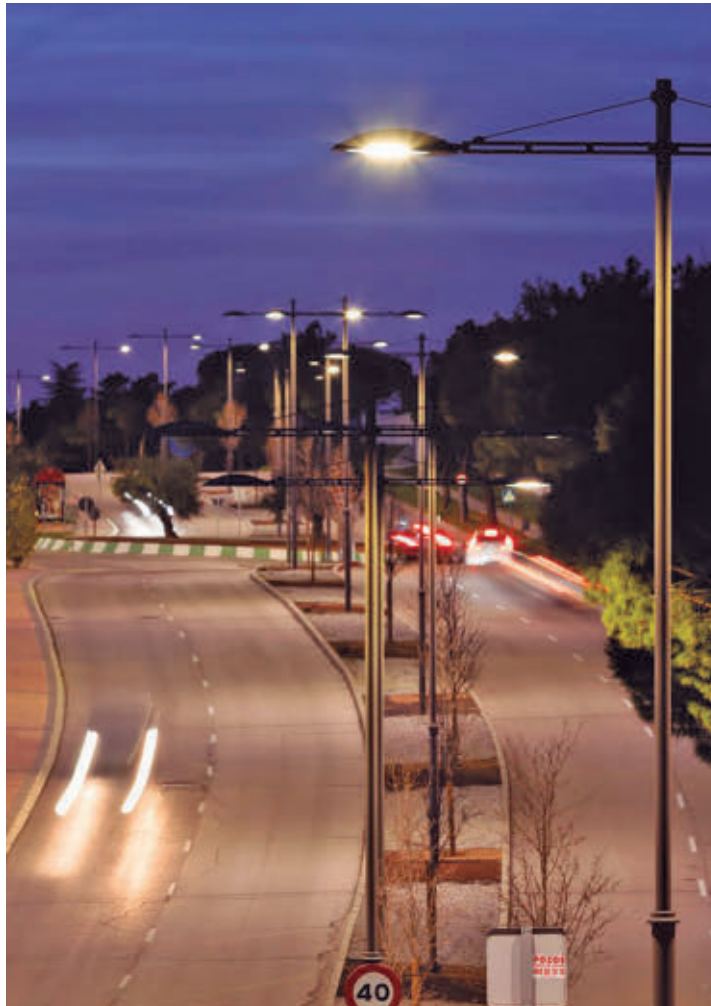
Algunas de las luminarias que se han instalado
