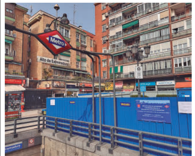
Las obras en la estación de Alto de Extremadura
