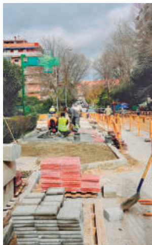
Obras llevadas a cabo
