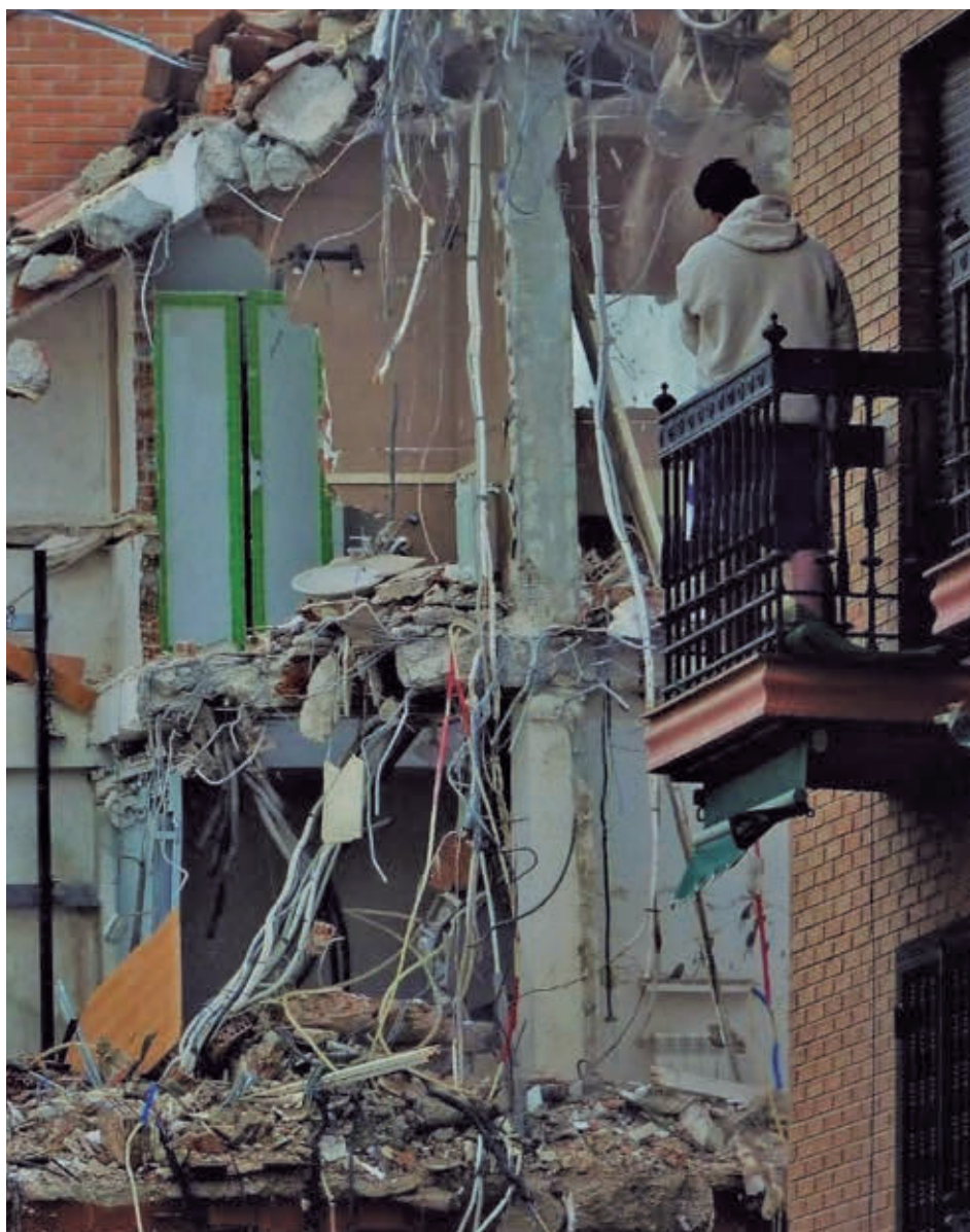
Imagen de archivo del derribo de viviendas por la Línea 7B de Metro EUROPA PRESS
