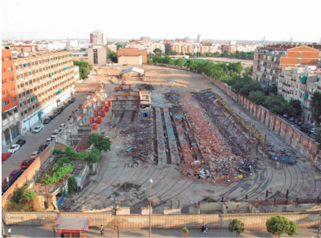
Los terrenos, tras la demolición de las instalaciones de Metro en 2021 @PATRINDUSTRIAL
