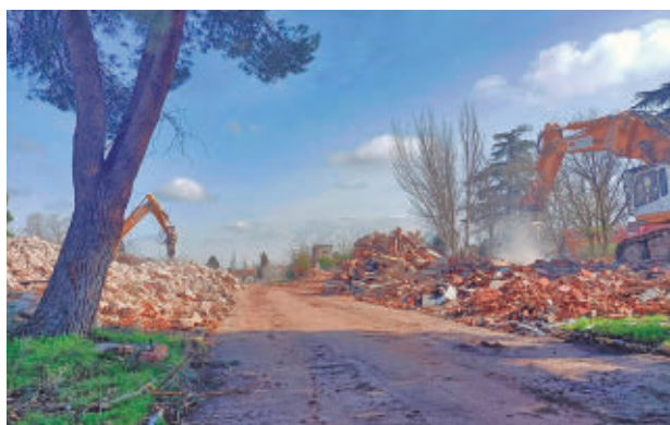
Los trabajos en las antiguas instalaciones militares
