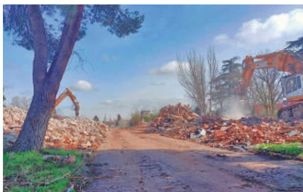
Los trabajos en las antiguas instalaciones militares
