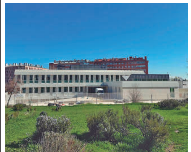
Estado actual del ambulatorio AVIB
