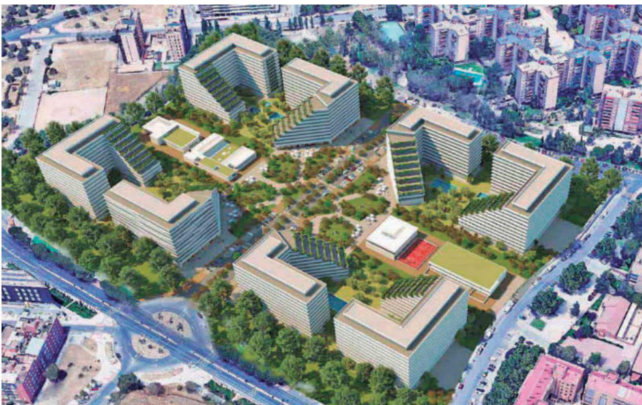
El Plan Parcial SUS R1 y el SUS R4 supondrán la activación de más de dos millones de metros cuadrados de suelo urbanizable
