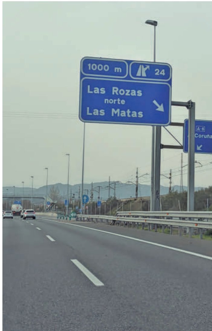
Salida 24 de la autovía A-6 a la altura de Las Rozas
