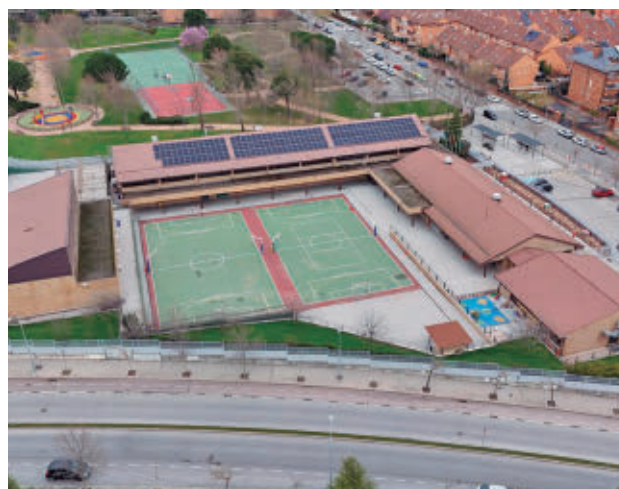
Placas solares en el tejado del centro
