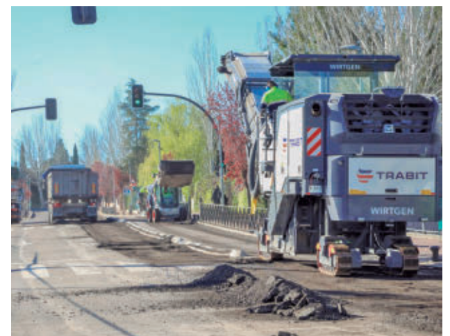
Ya se han iniciado los trabajos
