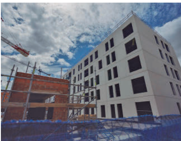
Una vivienda en construcción en la capital
