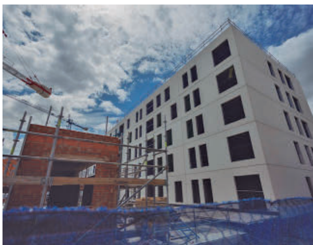
Una vivienda en construcción en la capital
