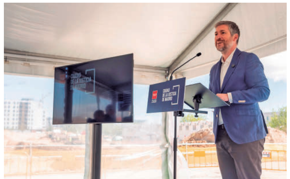
El portavoz regional visitó las obras esta semana
