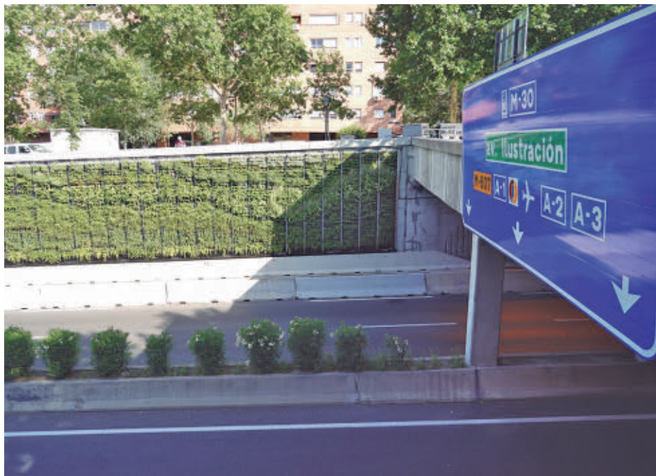
Los jardines verticales situados en el entorno de la Avenida de la Ilustración
