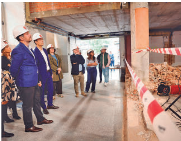
El consejero visitó las obras
