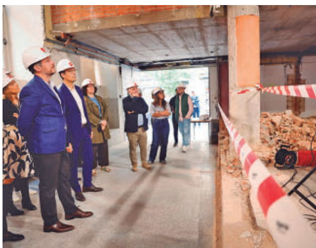
El consejero visitó las obras
