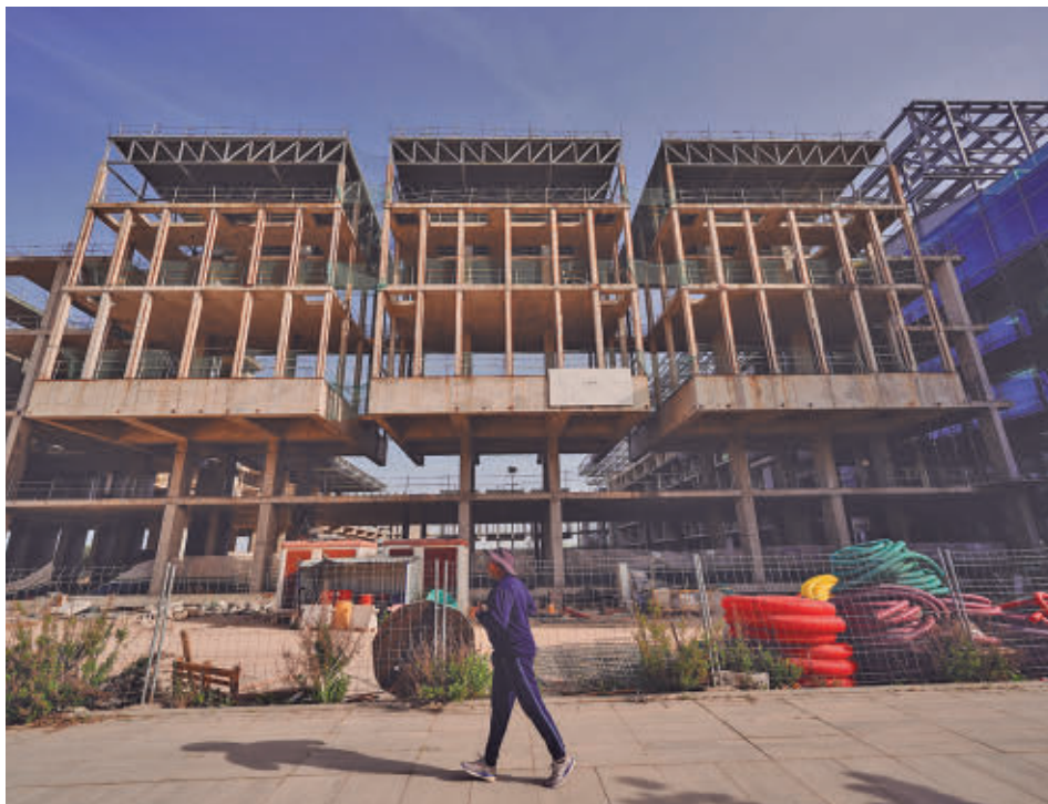
Las obras exteriores del antiguo Centro Acuático
