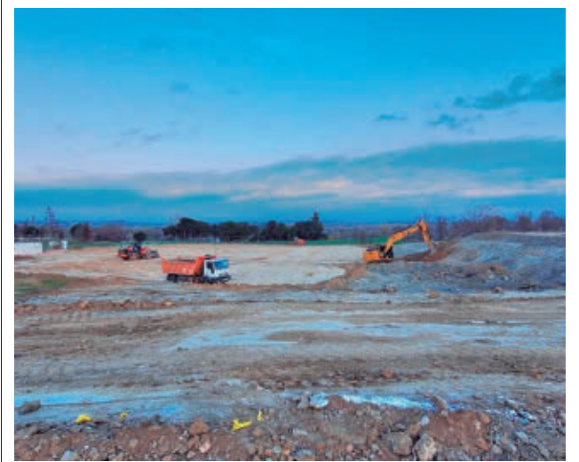
Las obras de construcción del cantón @COLEMASCANTONNO
