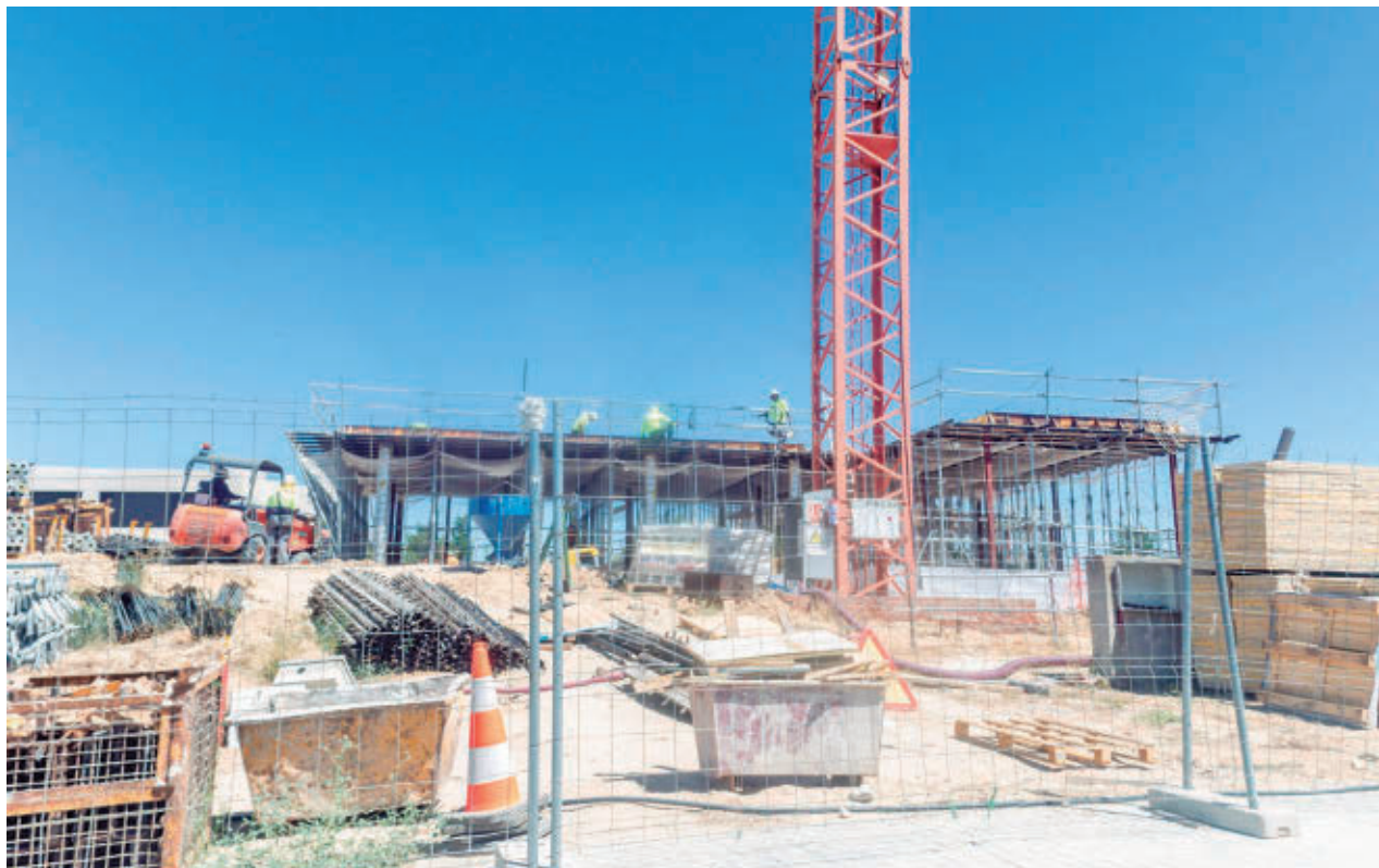
Bloque de viviendas en construcción en la Comunidad de Madrid EUROPA PRESS
