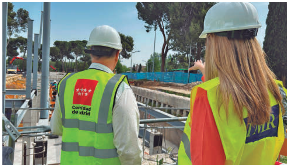
Estado actual de los trabajos
