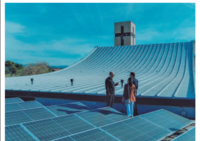
Visita a las obras de la cubierta
