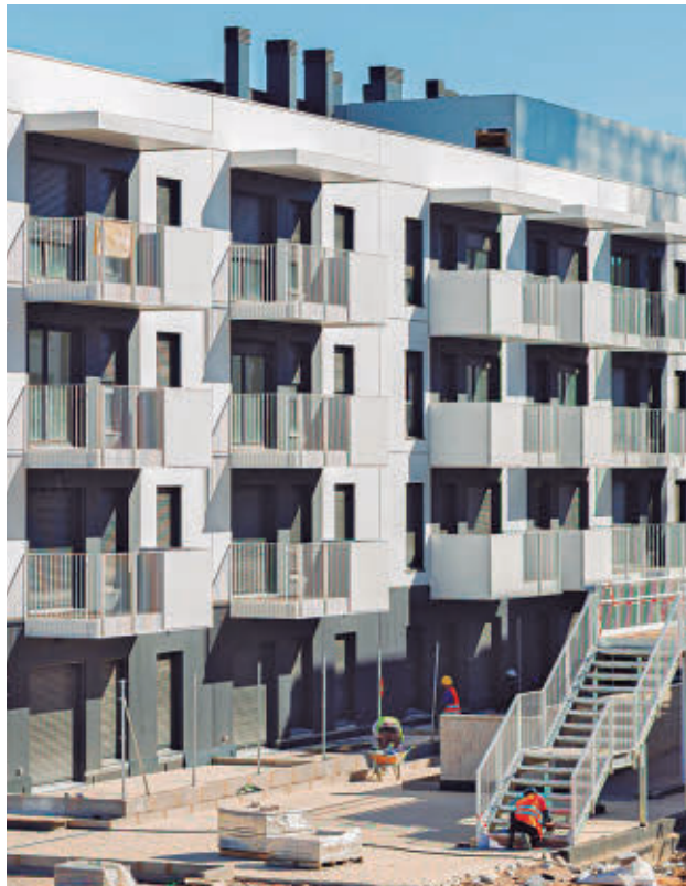
Viviendas en construcción en Boadilla
