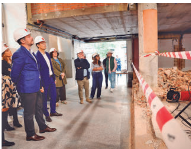
El consejero visitó las obras
