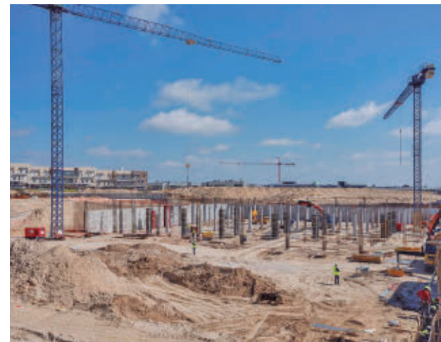
Viviendas en construcción
