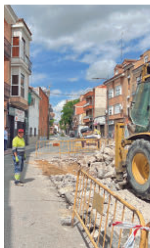
Estado de las obras
