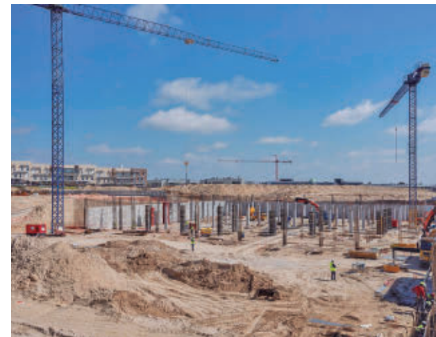
Viviendas en construcción
