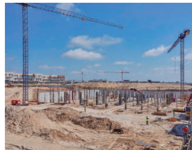
Viviendas en construcción
