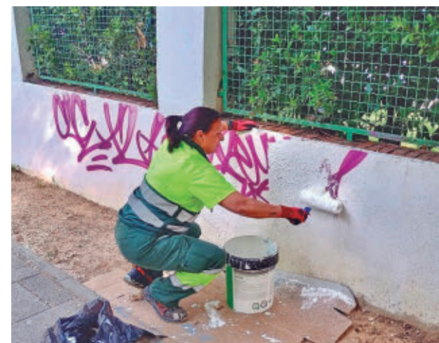
Una trabajadora limpia una de las pintadas
