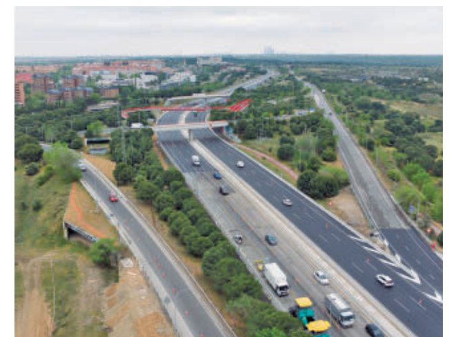
Vista aérea de la zona COMUNIDAD DE MADRID
