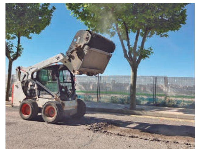
Las máquinas ya trabajan en la zona
