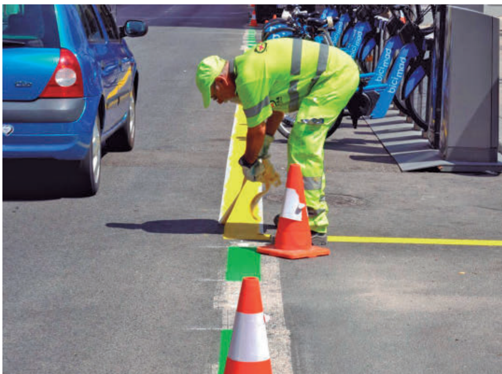
Un trabajador pinta las líneas que delimitan los aparcamientos reservados
