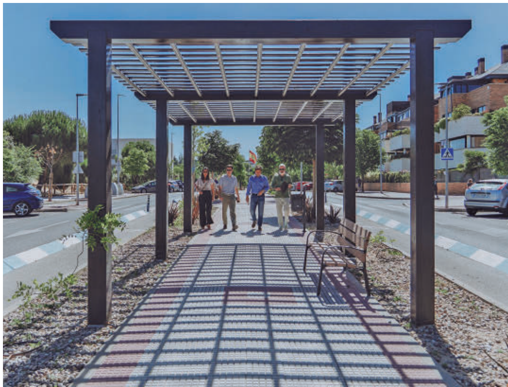
Una de las pérgolas que se han instalado en el bulevar de la calle Marie Curie
