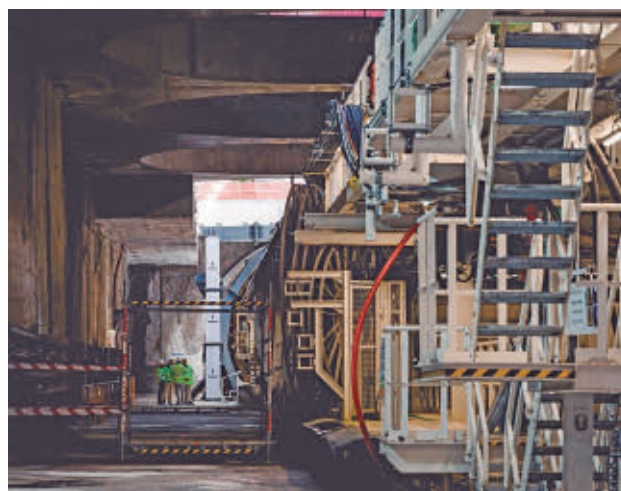
Obras de ampliación de la Línea 11 E.P.
