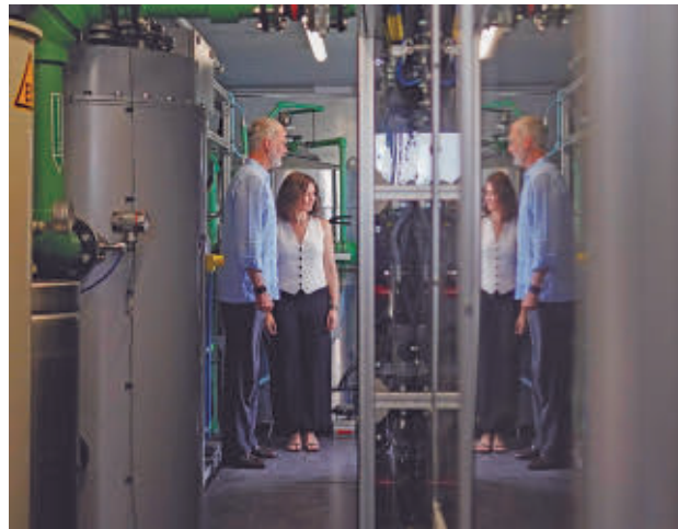
Interior de las instalaciones del Centro
