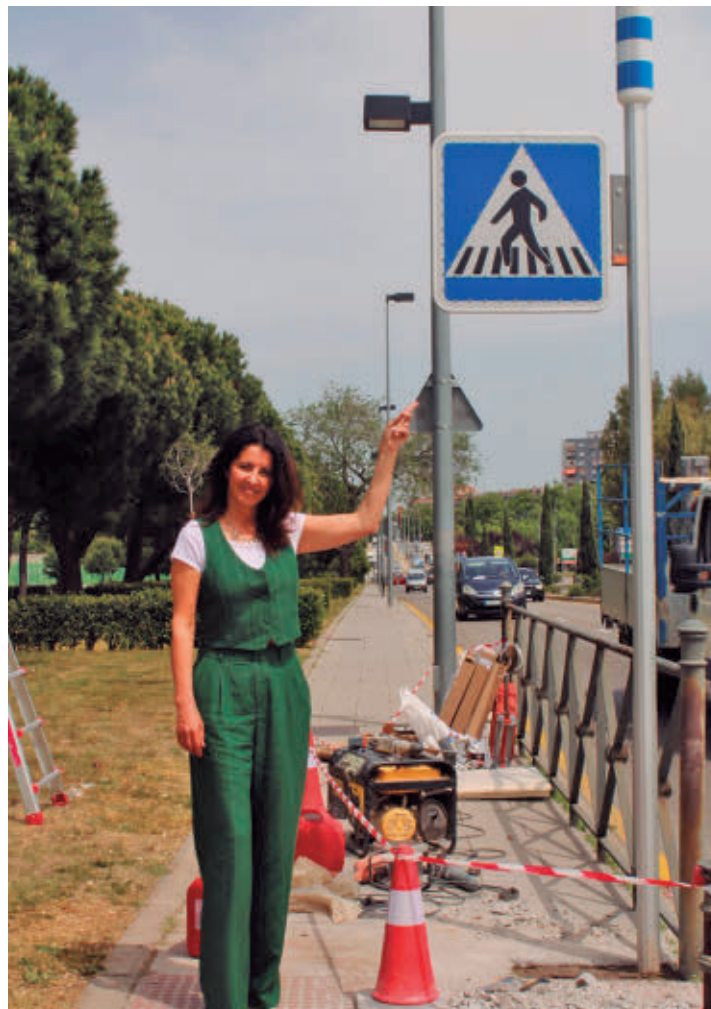
La concejala del área, Trinidad Castillo, visitó los trabajos AYO DE ALCORCÓN
